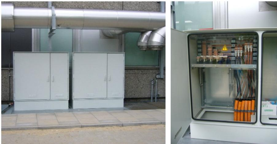
Abbildung 10: Vorbereiteter Aufstellort für eine mobile NEA mit Anschalteschrank und Abgasführung
