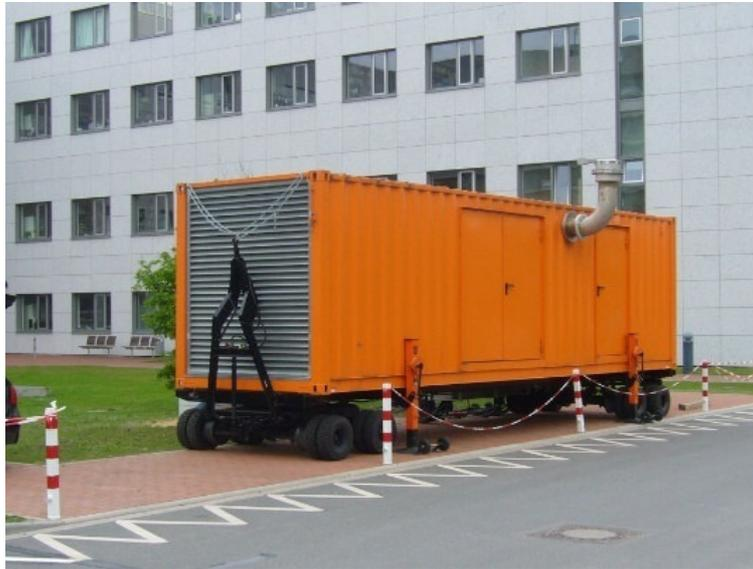
Abbildung 9: Mobile NEA auf einer geeignet vorbereiteten Aufstellfläche
